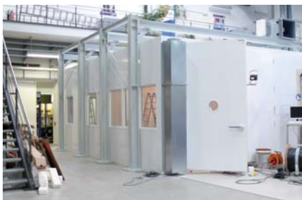
Abb. 3: Neuer Trockenraum am iwB
