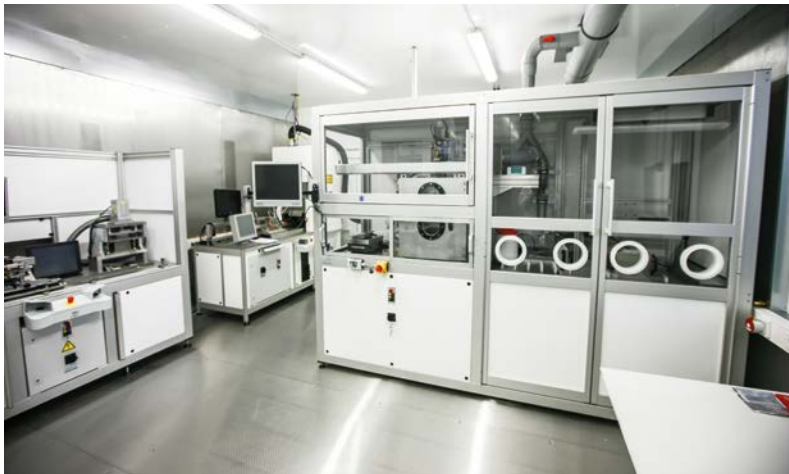
Ausschnitt des Trockenraums mit Anlagentechnik zur Fertigung von Lithium-Ionen-Zellen. (J.-F. Meis/iwb)
