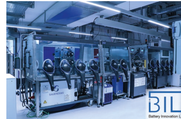
Abb. 3: Aufgebaute Laborlinie zur Zellassemblierung von Festkörperbatterien im Battery Innovation Lab (BIL)
