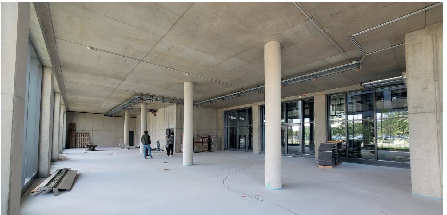
Abb. 3: TUM LfE Living Lab „Future Work“ - Rohbau
