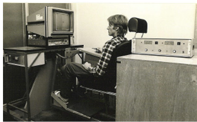
Abb. 4: Simulator zur Erzeugung von Rollschwingungen, der in verschiedenen regelungstechnischen Untersuchungen Anwendung fand
